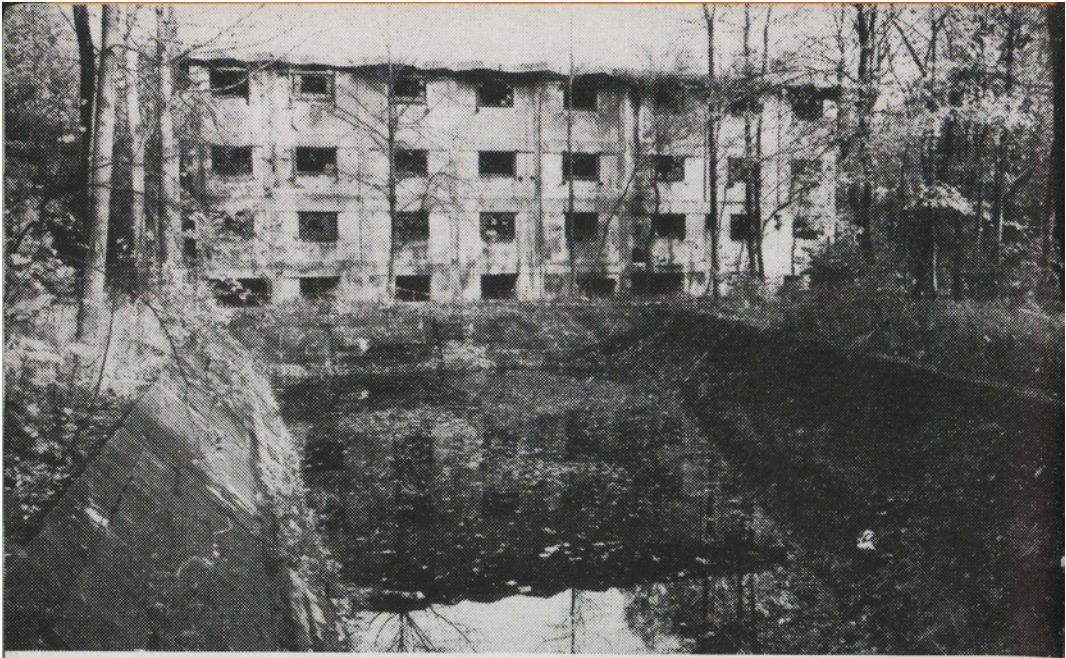
Abb. 4 Das »tote Gesicht« des leerstehenden Bunkers der Denitrierungsanlage (Nr. 313) spiegelt sich im Feuerlöschteich.
